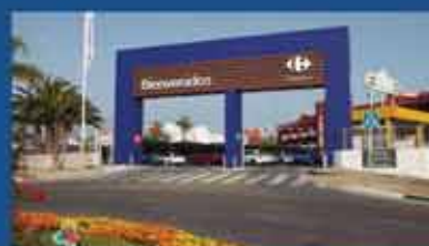
Carrefour Estepona Ctra. Cádiz-Málaga Km 156.9
